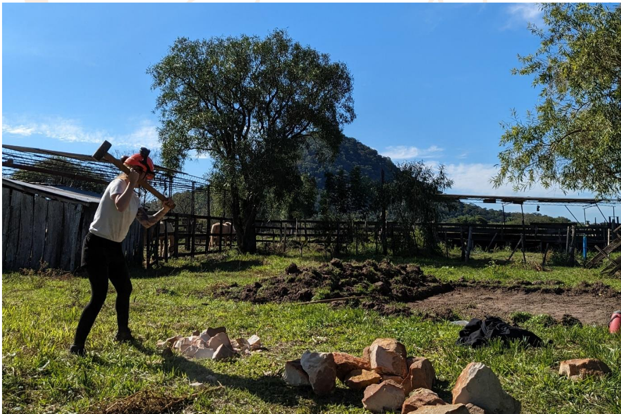
(Anni beim zerschlagen von Steinen für einen Häuserbau in Paraguay)
